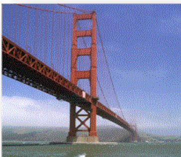
Fig. 2.1 Pont du Golden Gate (San Francisco) [29].
