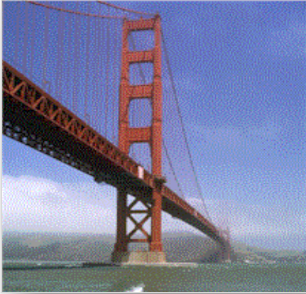
Pont du Golden Gate (San Francisco) [29].
