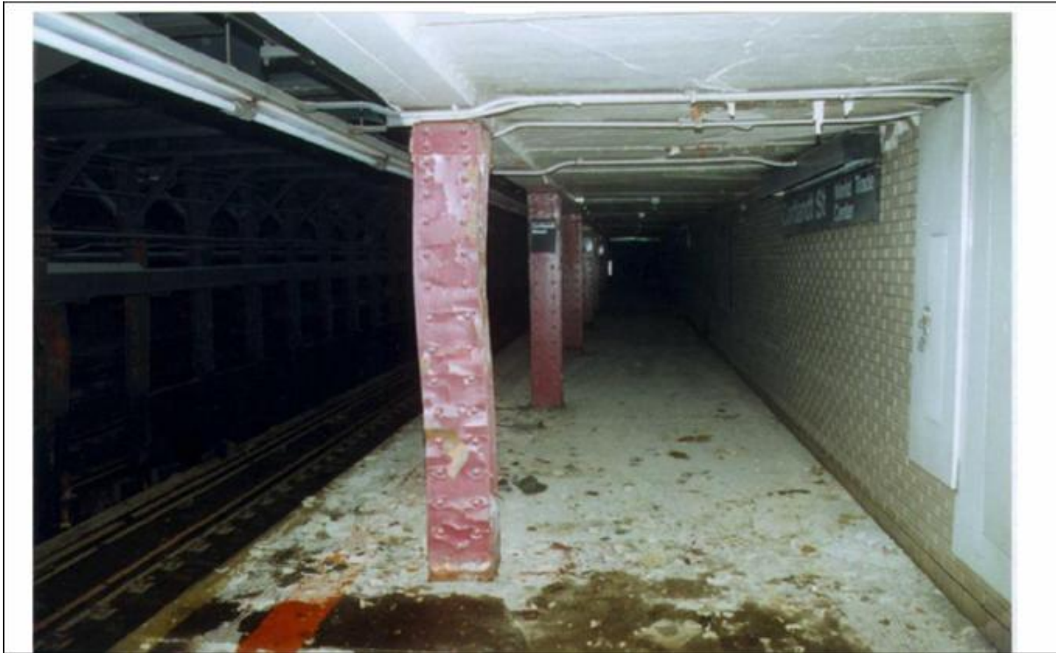
Exemple de flambement d'un poteau
