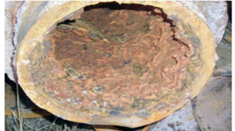
*Entartrage par dépôt calcaire*
