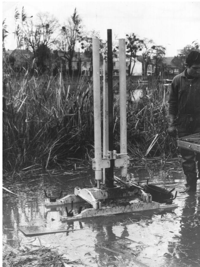
Figure 4 : Mise en œuvre de scissomètre à l'aide d'un bâti ancré.
