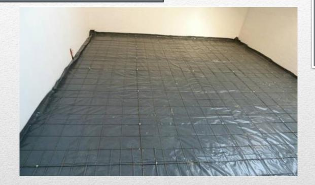
Une membrane étanche ou film plastique permettant de protéger la dalle en béton de humidité. D'une épaisseur 200 microns, c'est un film polyéthylène en rouleaux de largeur 3,00m
