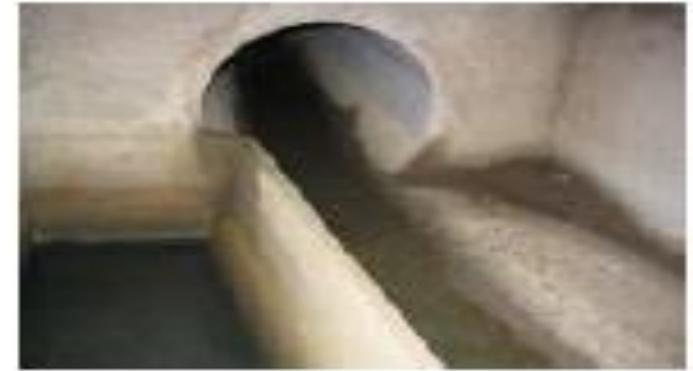
Déversoir d'orage avec dégriffleur à fines lames intégré dans le déversoir de traitement.
