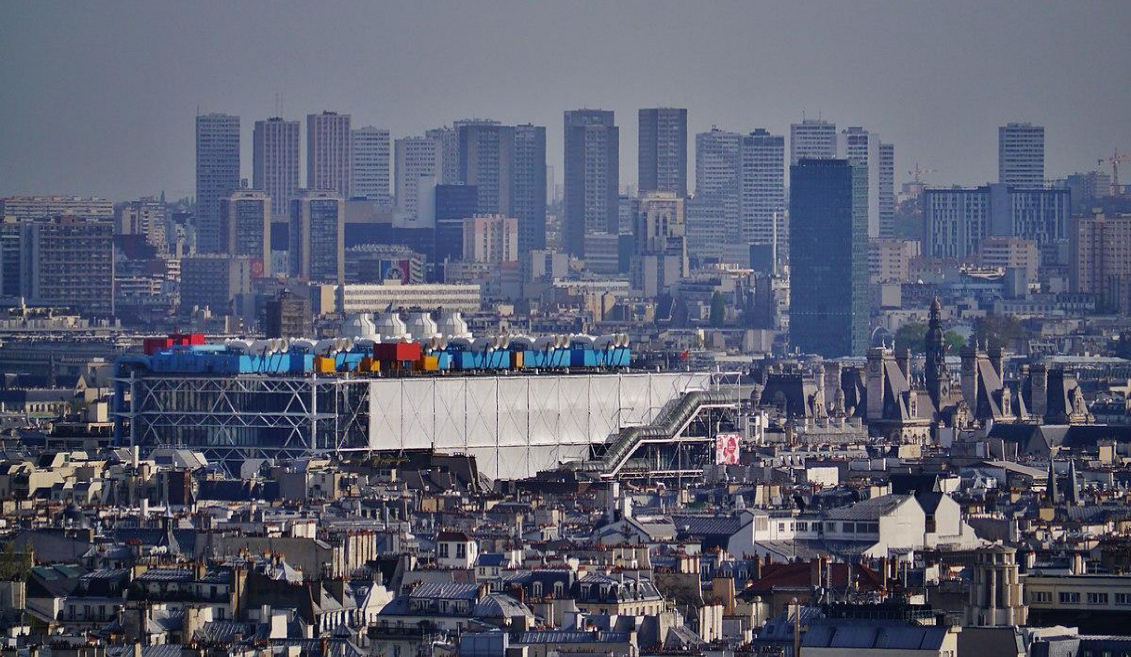
Le centre Georges Pompidou dans son contexte urbain au cœur de Paris
