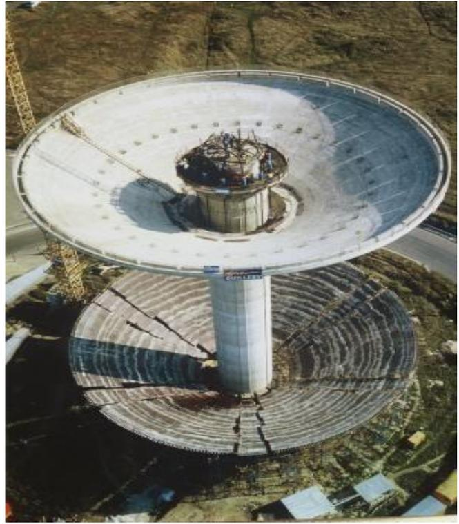
*Photo 29 - Levée de la cuve par câbles*
