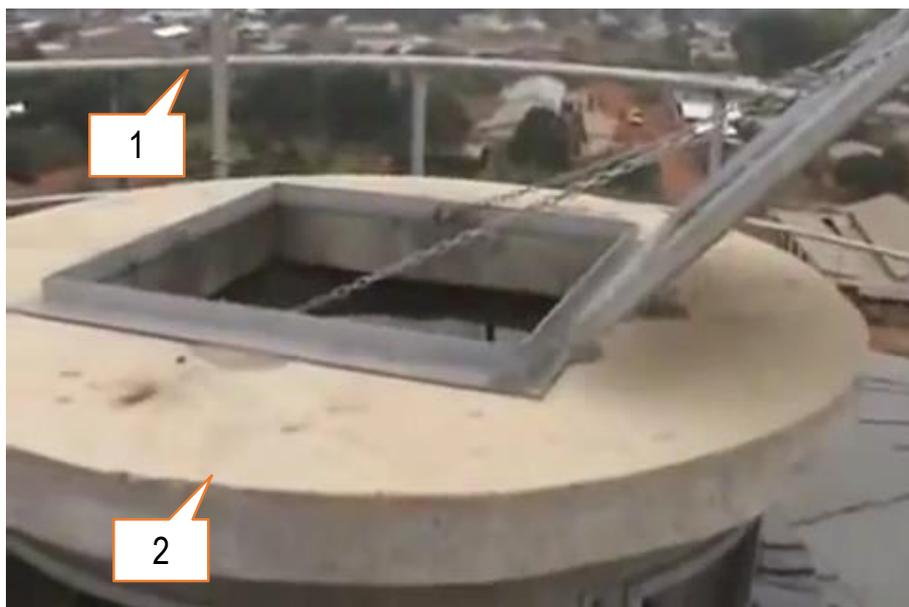
Figure 5 – Equipements de sécurité : le campanile d'accès et les garde-corps
