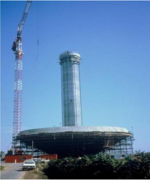
*Photo 28 - Coffrage au sol de la cuve*
