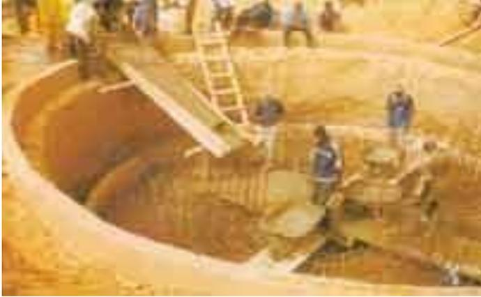
*Photo 9 - Début de réalisation d'une fondation de château d'eau après fouille*
