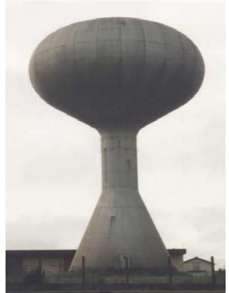
*Photo 6 - Réservoir à cuve sphéroïdale*
