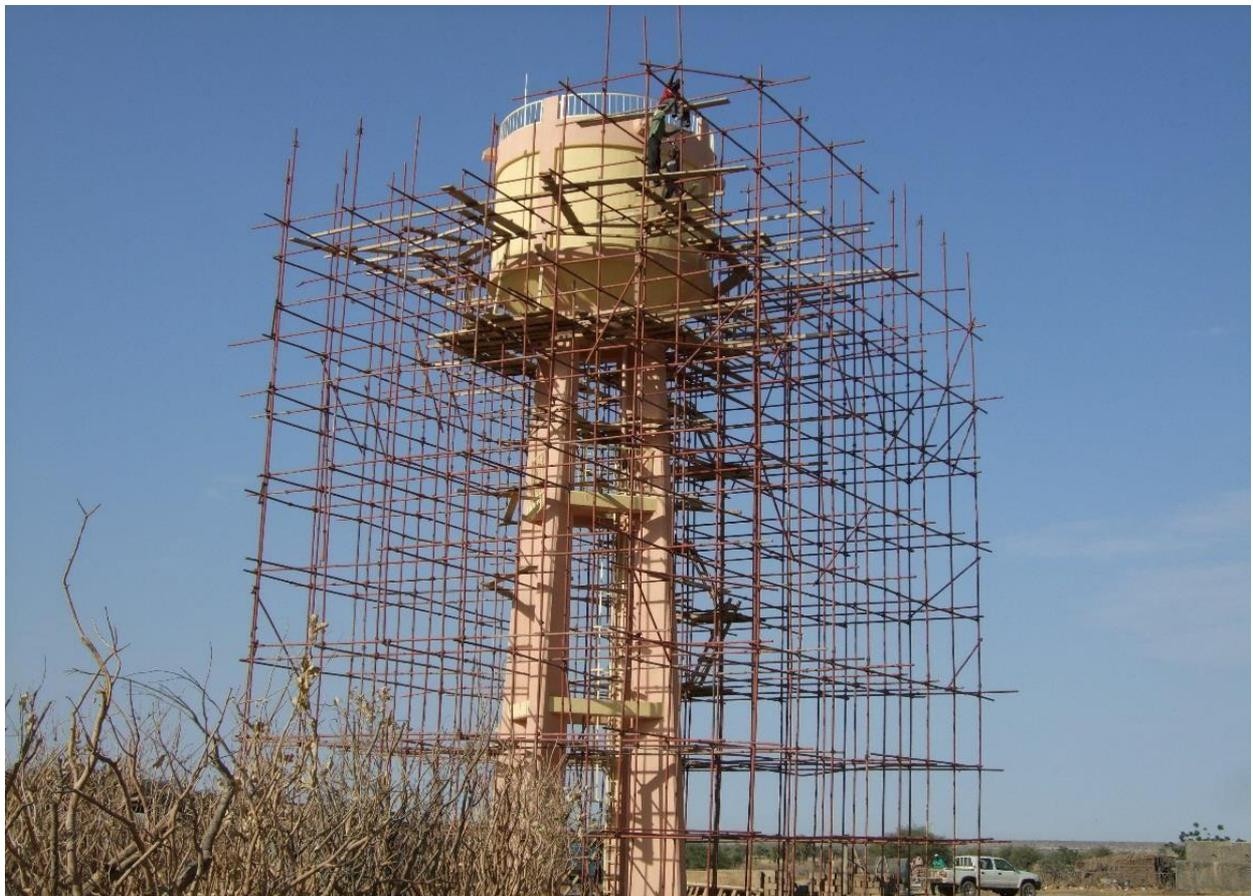
Photo 24 - Echafaudage pour la réalisation de la cuve
