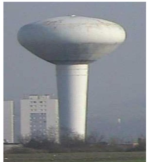
*Photo 7 - Réservoir à fond sphéroïdal*
