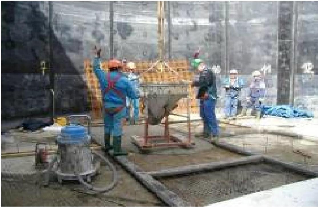
*Photo 36 – Coulage du béton entre les nus*
