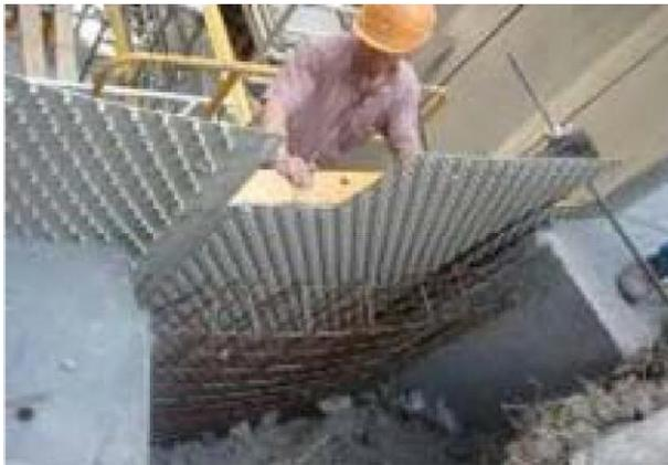
*Photo 41 – Réserve pour la pose d'une poutre*
