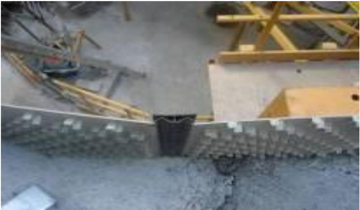
Photo 34 – Raccordement des panneaux par le Profilé « à déchirer »
