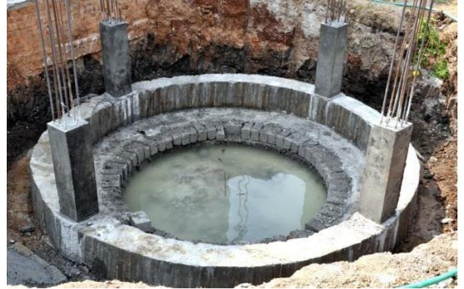
*Photo 8 - Fondation d'un château d'eau réalisée*
