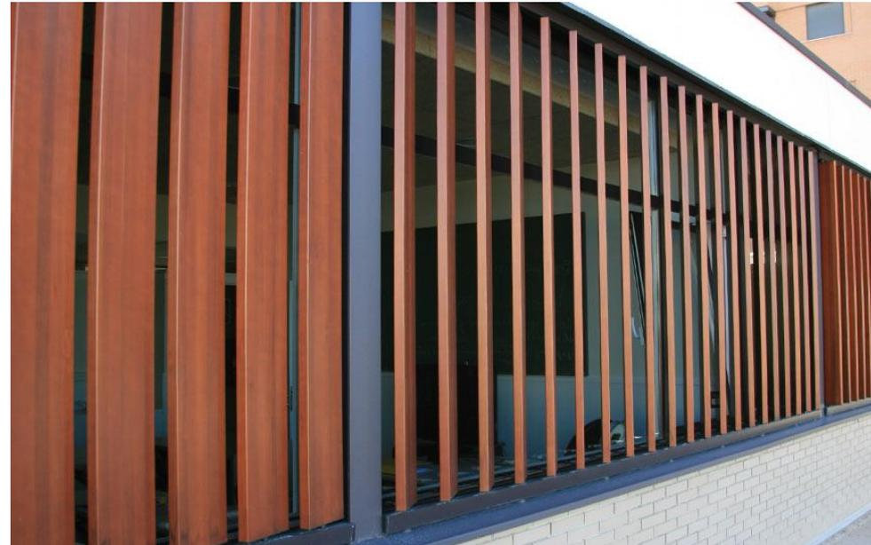
protéger au maximum des entrées solaires par les ouvertures au moyen de **brise-soleils**
