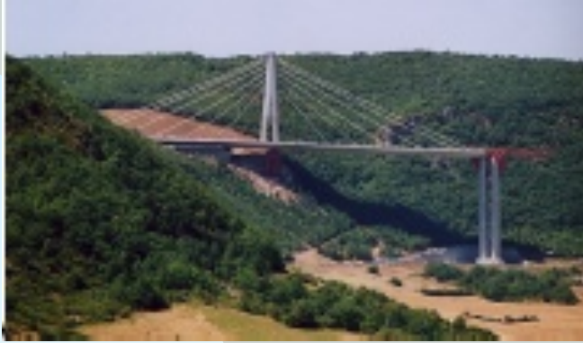
Pile du viaduc de Millau
