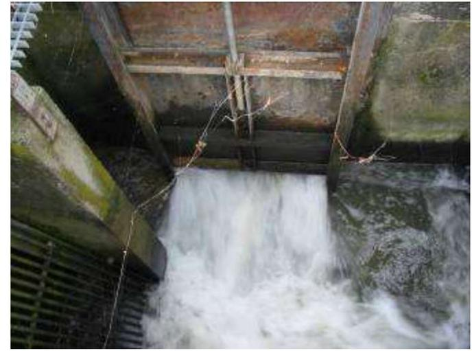
l'expression de Torricelli, c'est une vitesse théorique qui est supérieure à la vitesse réelle à cause de l'influence des pertes de charge à la sortie de l'orifice.
