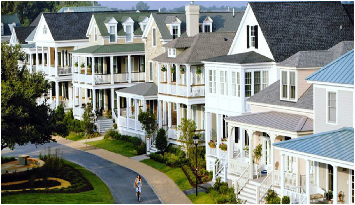
Fig. 96. Quartier du Norfolk VA East Beach. Source : Site internet visualisé le 06/02/2017 à 12h58 URL : http://www.eastbeachnorfolk.com/
