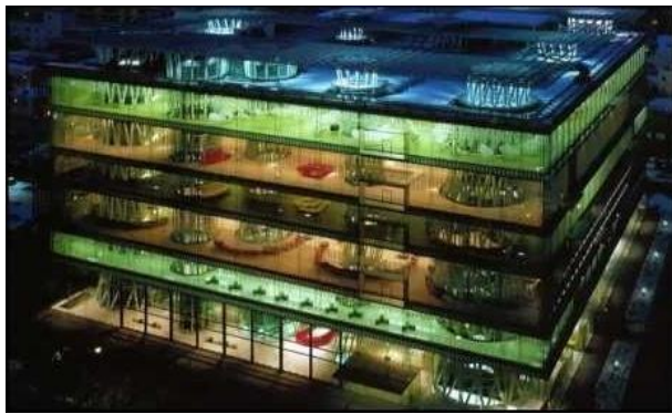
Figure 6.7. La Médiathèque de SENDAI : Les 13 faisceaux sont recouverts de structures tubulaires en acier en verre, la structure organique ressemblant à un analogue à une algue, et les plates formes de support transversal, de faire saillie dans le plafond.
