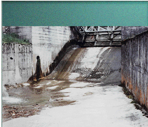
Figure II.17. Erosion par les matériaux charriés et disparition de l'enrobage au niveau de l'évacuateur des crues.
