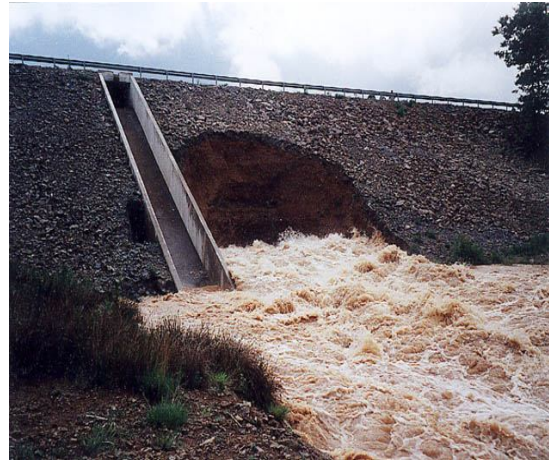
Figure II.6. Erosion régressive sur un barrage enterre.
