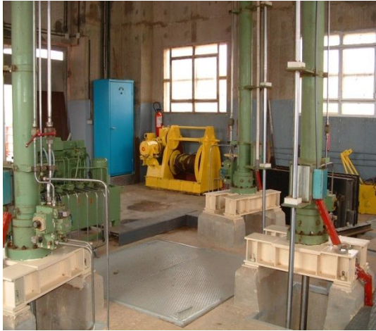
Figure II.25. Equipements hydromécaniques concernés par les essais périodiques, barrage
