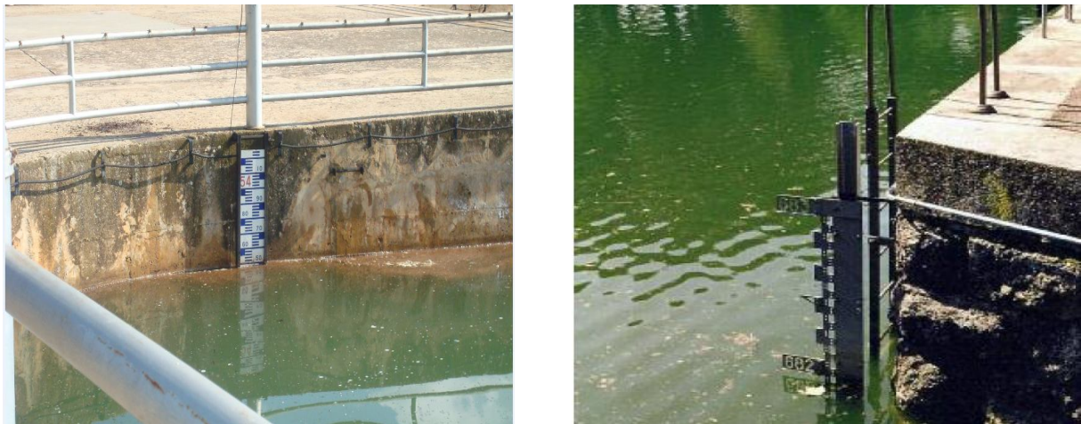
Figure III.2. Echelle limnimétrique installé au niveau du corps du Barrage Beni Bahdel, Wilaya de Tlemcen, Algérie [79].
