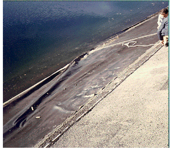
Figure II.16. Déchirure du masque amont.
