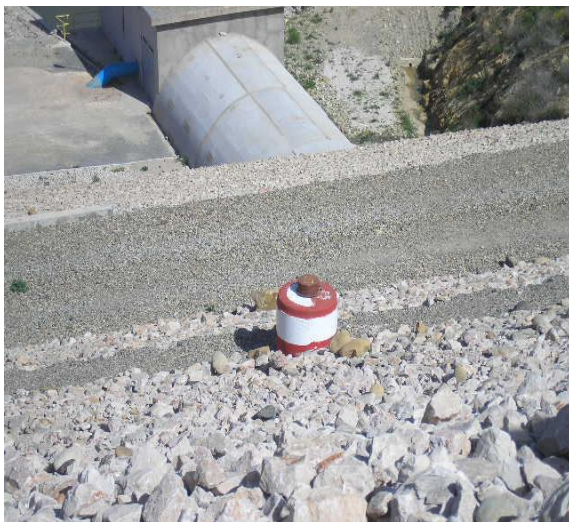
Figure III.8. Borne sur talus aval servant aux mesures des déplacements, Barrage Sidi Abdelli, wilaya de Tlemcen.
