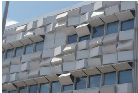
Figure 50 : Façade faite de protection escamotable
