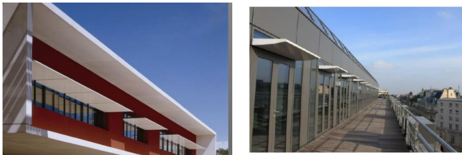
Figure 40: Les étagères à lumière dans les bâtiments
