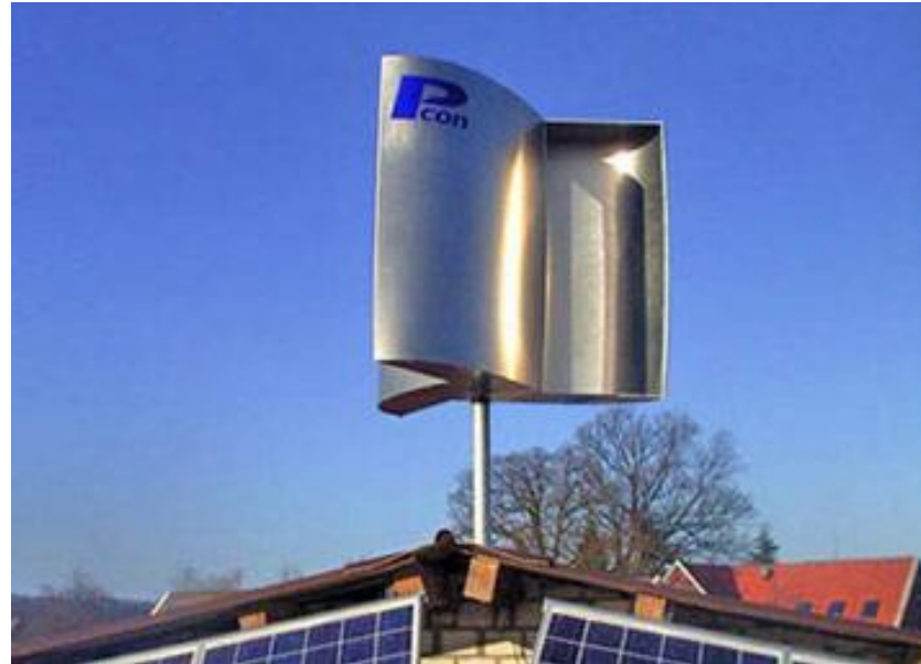
Éolienne à axe vertical de type Savonius intégrée sur une toiture en Allemagne
