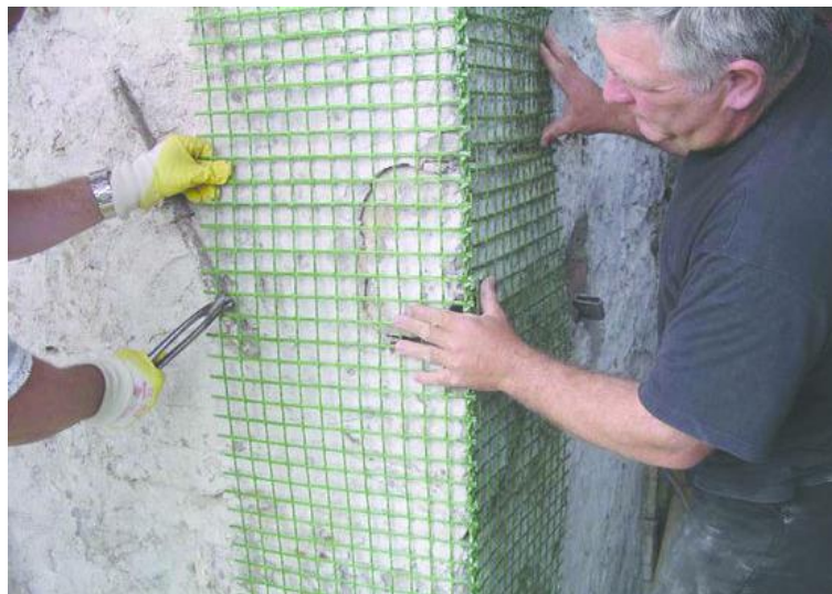
Figure 29. Introduction d'une armature pour la reprise d'enduit
