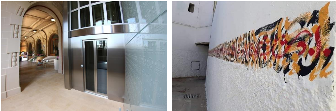
Figure 1. Intervention suivant le besoin d'accessibilité à gauche, et d'hygiène à droite
