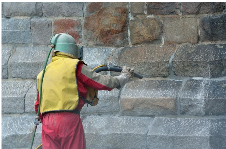
Figure 24. Nettoyage par sablage
