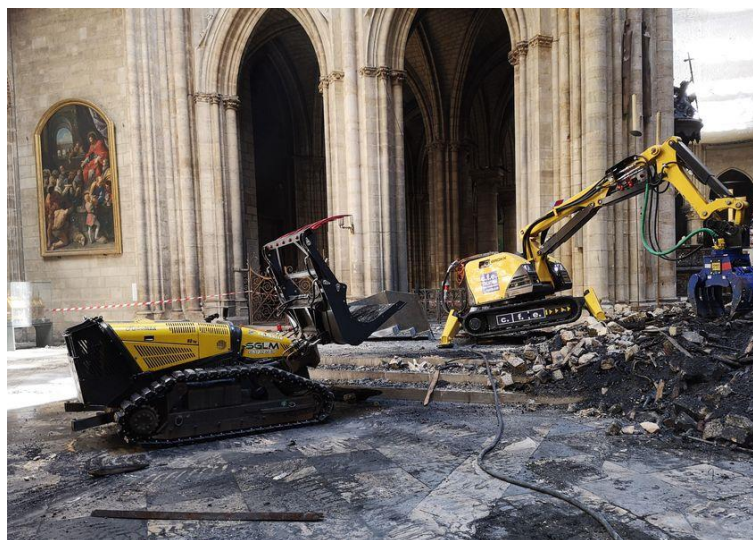
Figure 16. Démolition mécanique minutieuse à l'intérieur de la cathédrale de notre dame de Paris
