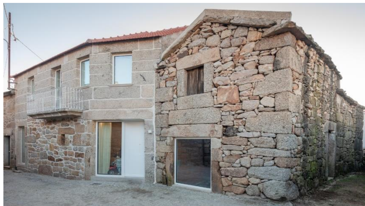
Figure 10. Rejointoiement différent du joint d'origine, House of Grandfather Martinho, Portugal
