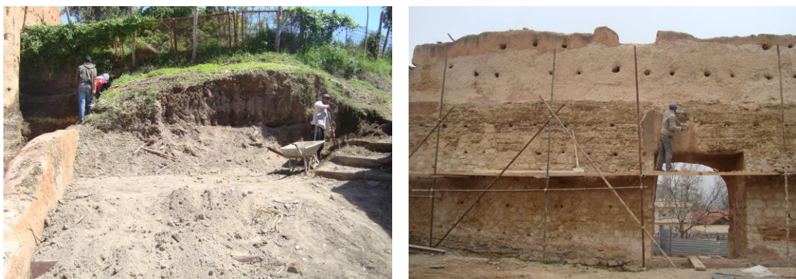
Figure 15. Décapage des terres (à gauche), et des enduits (à droite). Source Selka Chihab
