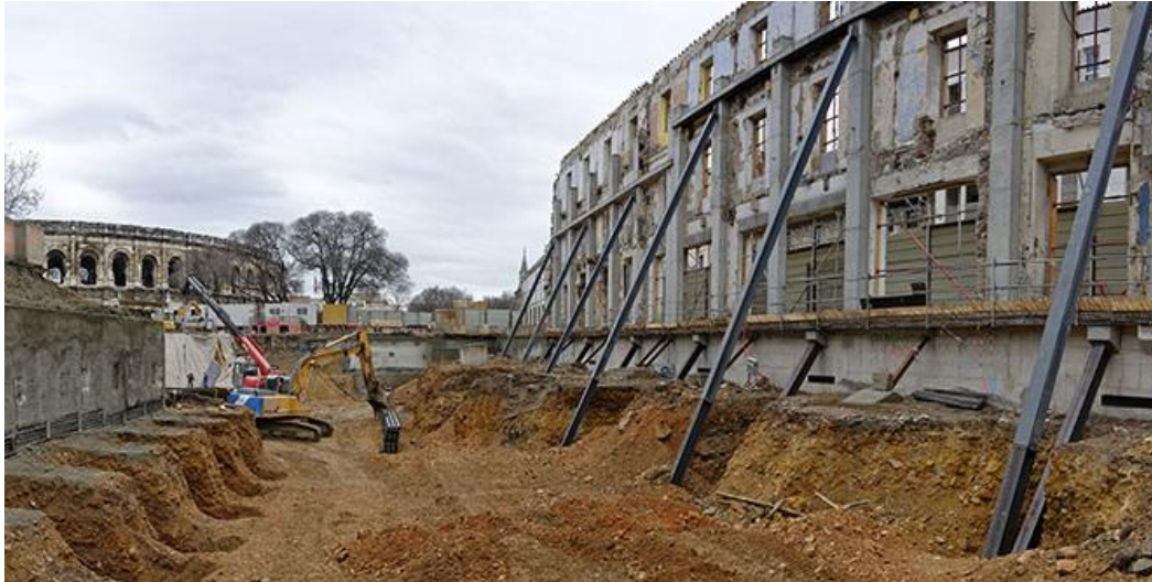
Figure 19. Etayement d'un ancien édifice avant le remblai dans ses abords
