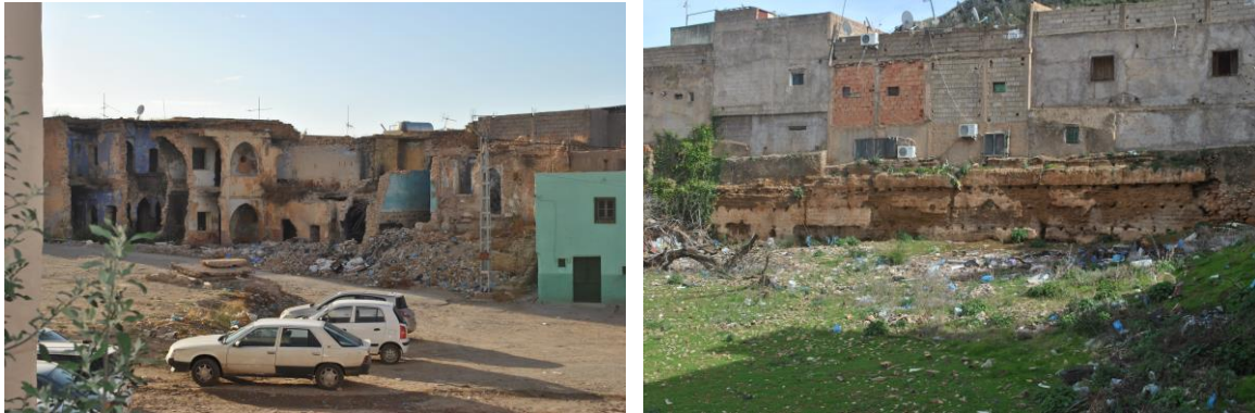
Figure 7. Destruction d'un quartier ancien à l'aide d'une bombe (à droite), et construction pardessus un mur en pisé (à gauche). Source Selka Chihab
