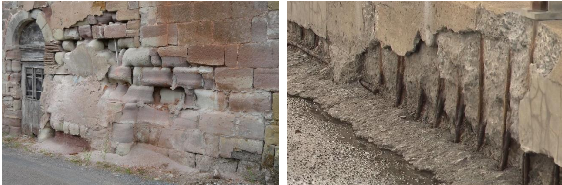
Figure 4. Lésion physique (à droite) et chimique (à gauche)
