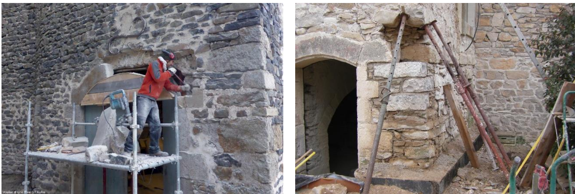
Figure 32. Mise en place d'étaisement avant le remplacement
