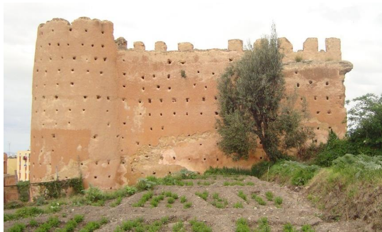
Figure 6. Exploitation agricole en contact direct avec un mur en pisé (source Selka Chihab)
