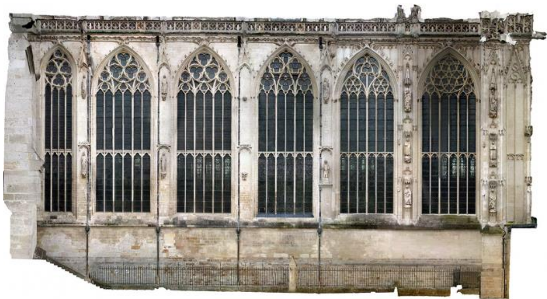
Figure 3. Relevé d'un pan de façade de la cathédrale d'Amiens en photogrammétrie. Source Antoño Almagro Gorbea
