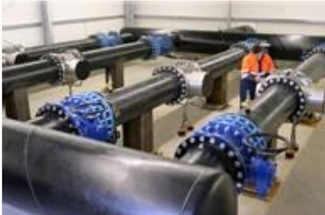
Plus grand système de désinfection par rayon UV , installé dans une usine de traitement de l'eau en Allemagne. Chacune des quatre chambres désinfecte jusqu'à 1060 m<sup>3</sup>/h
