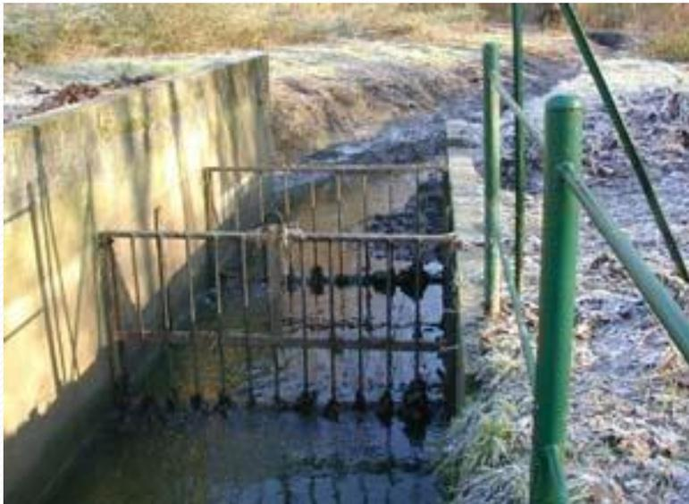
Dégrilleur destiné à retenir les objets flottants avant l'entrée d'un étang
