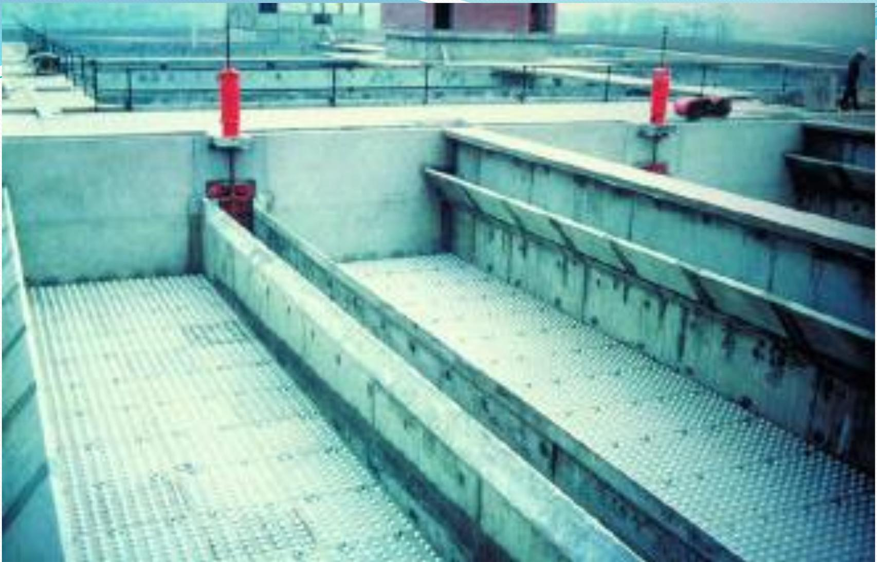
Filtres AQUAZUR Yen cours de construction; vue ester armé, du plancher filtrant avec ses busettes, de la goulotte de balayage en Y et de la goulotte de départ des eaux de lavage.
