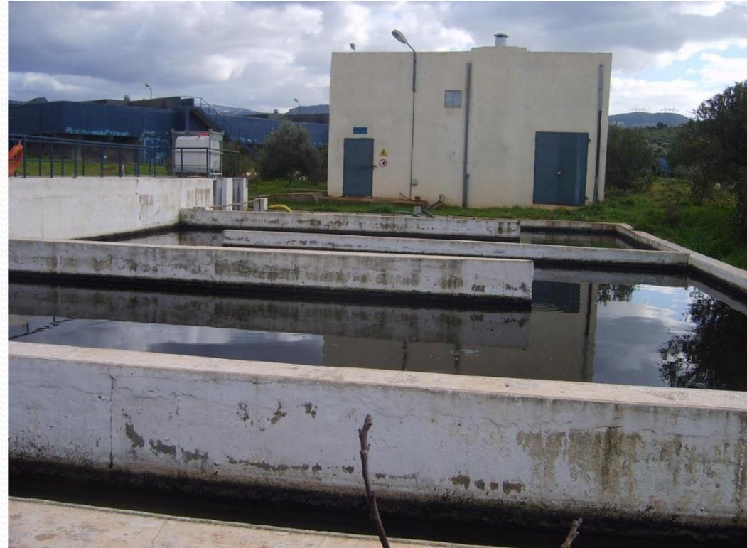
Parmi les procédés de désinfections, on trouve, le chlore, l'ozone, les rayonnements ultraviolet, etc. Mais la stérilisation par le chlore reste le moyen le plus pratiqué. Pour être efficace, elle nécessite un temps de contact minimal de 15 mn et si on veut obtenir plus de 99 % de rendement, les doses doivent être de 3 à 10 mg/l après l'épuration par lit bactérien et de 2 à 8 mg/l après l'épuration à boue activée.
