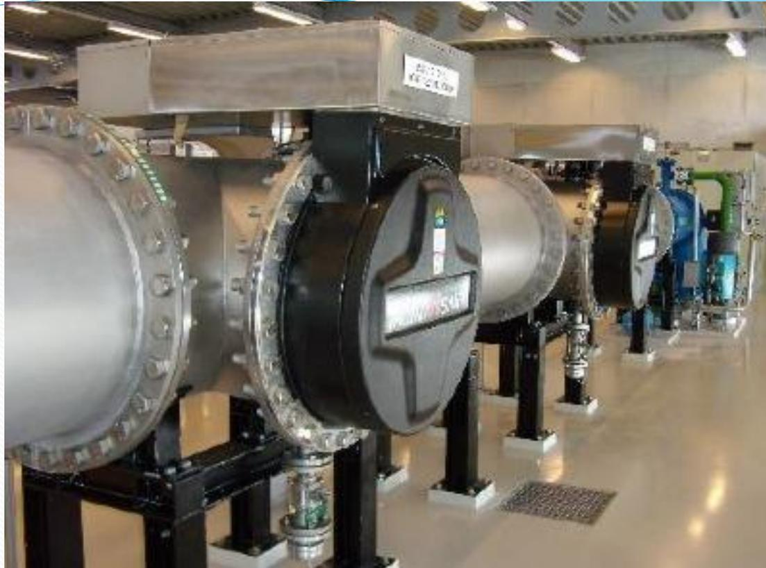
**Trojan Technologies Europe** a fourni, pour la ville de Rotterdam, la plus grande installation de traitement UV en Europe. Les 24 réacteurs (2 x 12) UV Swift peuvent traiter 16'000 m<sup>3</sup>/h.
