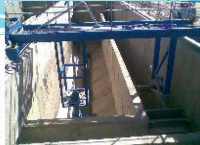
Le dessableur doit être conçu pour que la vitesse de l'eau à l'intérieur de l'ouvrage soit comprise entre 0,2 et 0,4 m/s.
