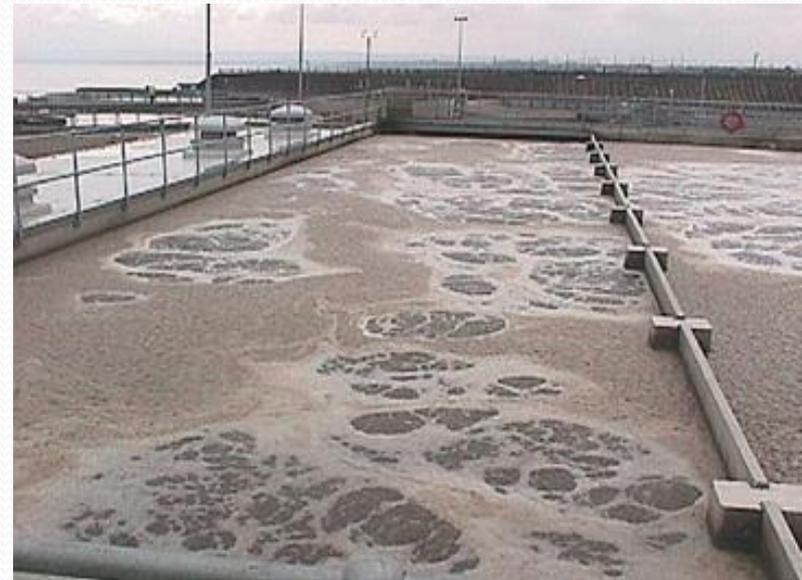
Le principe du procédé consiste à provoquer le développement d'un floc bactérien dans un bassin alimenté en eau à épurer en brassant suffisamment le milieu pour éviter la décantation des floccs d'une part et fournir l'oxygène nécessaire au développement des bactéries et maître en contact les micro-organismes avec le substrat d'autre part.
