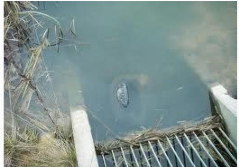
Exemples de flottants retenus par un dégrilleur.
