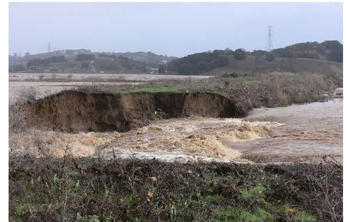
Rupture d'une digue à Novato (Californie) en 2005. © jessicafm CC by 2.0
