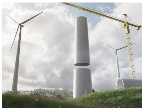
Figure I.3 : Tour en cours de montage
