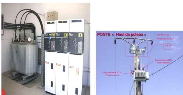
Types des postes de transformation HTA/BT
