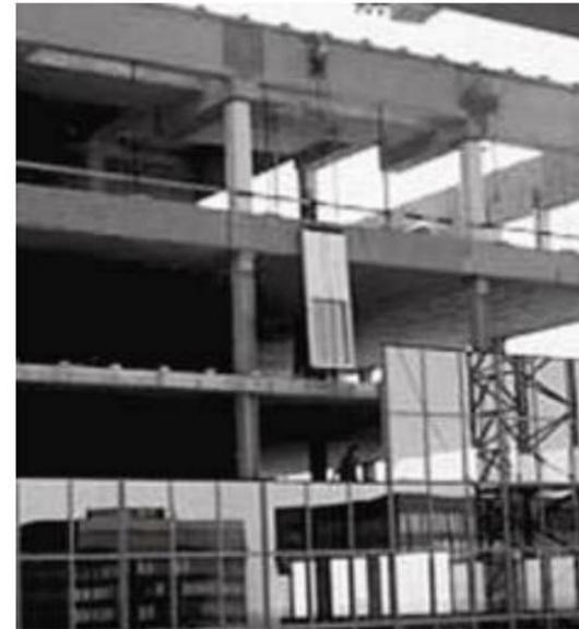
**Le mur-rideau monté en panneaux fixés à l'ossature du bâtiment
