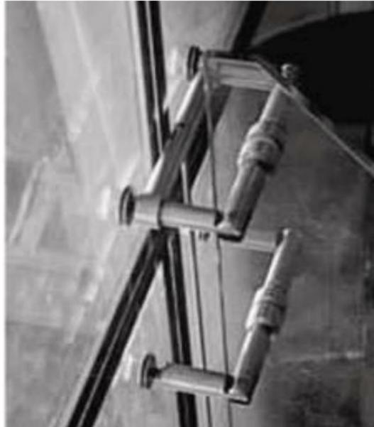
**Le mur-rideau en “verre structural” constitué de lames de verre liées par des joints adaptés et une structure « spider »**
