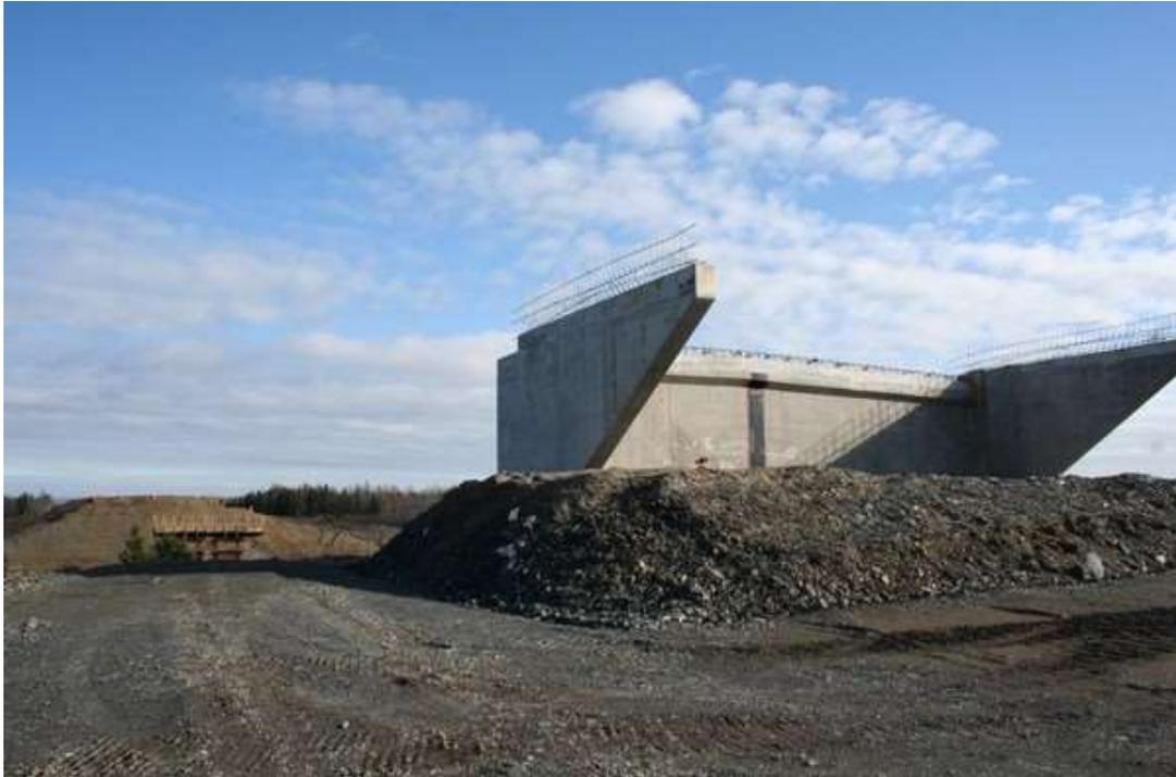
**Les piles :** se sont les appuis intermédiaires. Un appui peut être composé par un ou plusieurs voiles ou par des colonnes surmontées par un chevêtre.
