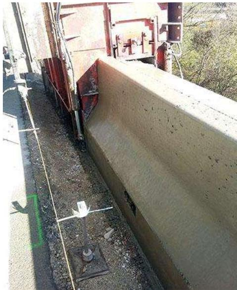
Glissière Béton Adhérent (GBA) / séparateur double en béton adhérent (DBA)
