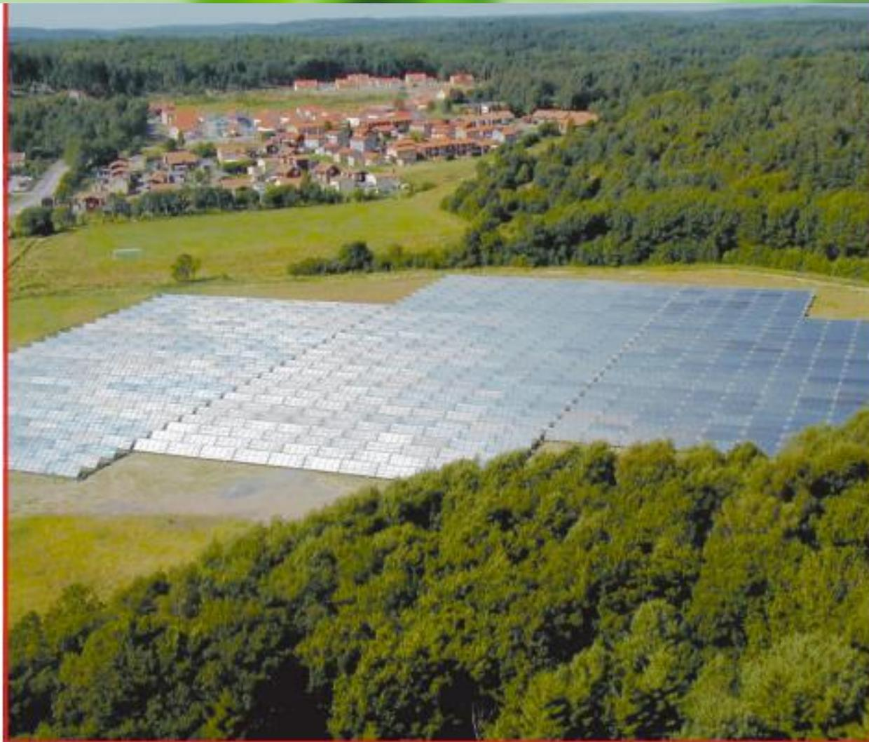
Le réseau de chaleur de Kungälv (Suède) alimenté, en partie, par les 10 000 m<sup>2</sup> de capteurs solaires thermiques.
