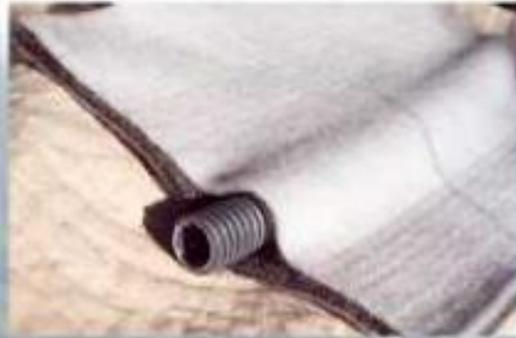
Exemple : Géocomposite de drainage
