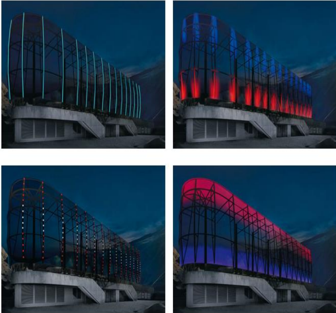
Figure III.40. Mise en lumière pour modifier l'architecture Source : Zumtobel 67
