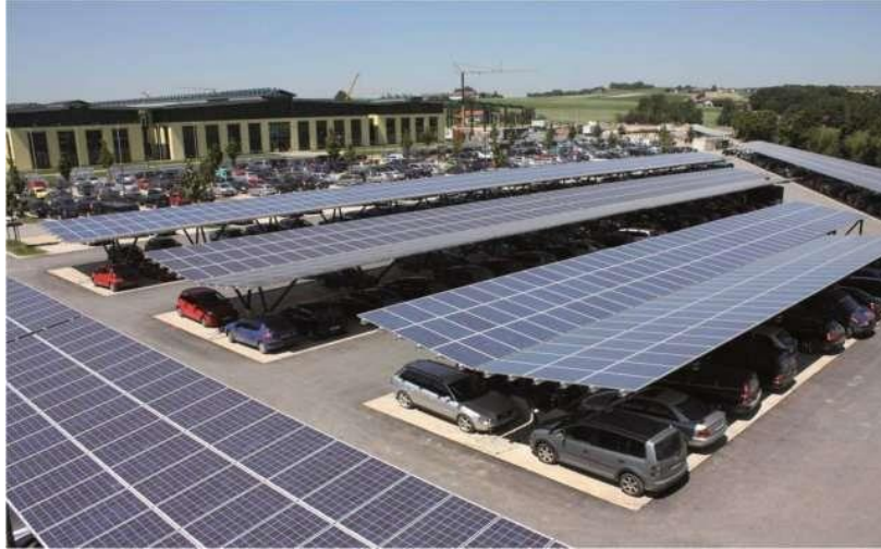
Figure V.16. Carport Source : particuliers 96
