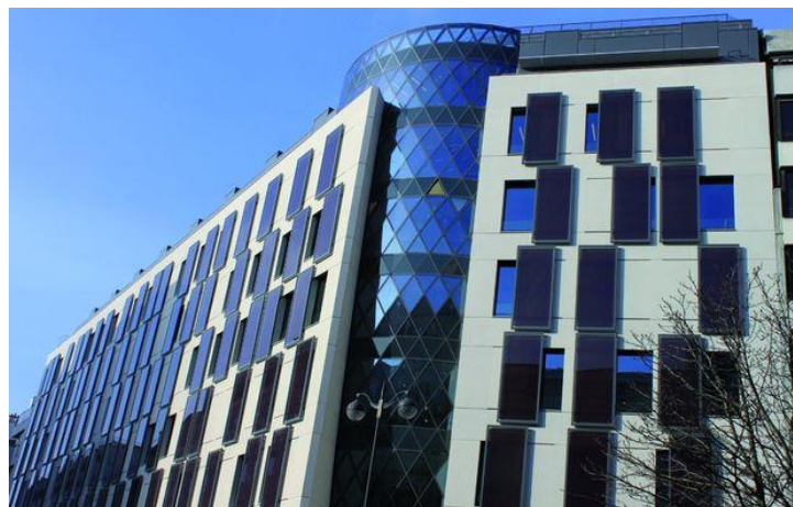
Figure V.15. Volets solaires Source : Le moniteur 95
