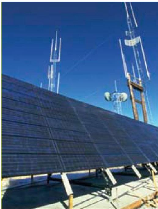
**Figure 120.** *Utilisation du photovoltaïque pour une station de télécommunication isolée*
