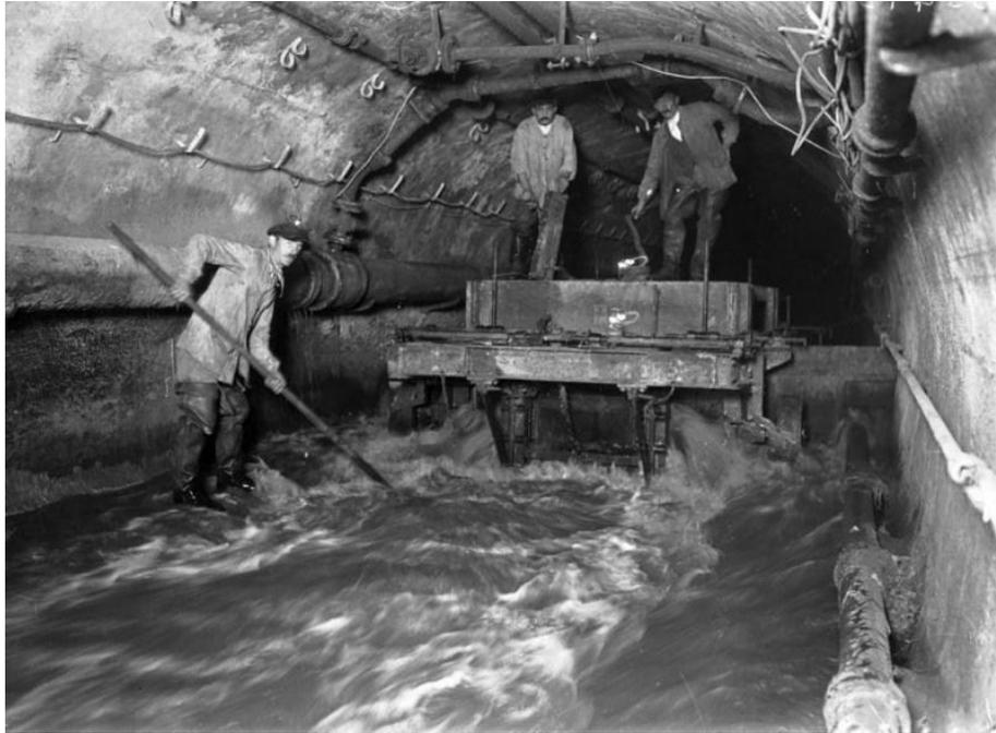
**Figure 51.** Réseau d'assainissement souterrain à Paris
