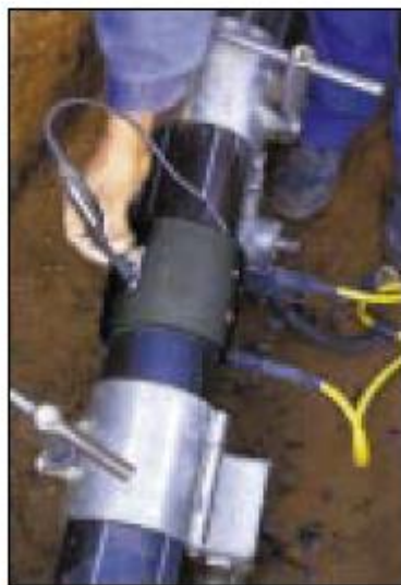
(b) Électrosoudage sur PE
