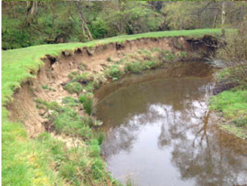
Erosion des berges
