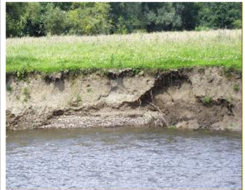
Affouillement des berges
