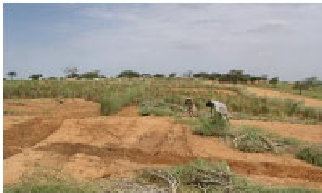
Mise en place des tranchées de fixation mécanique
