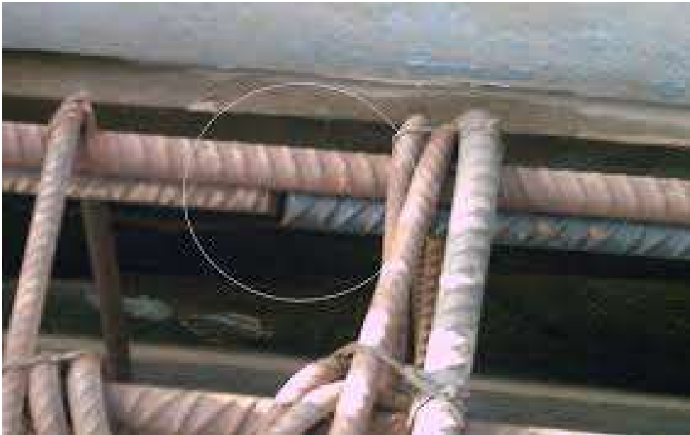
Jonction de barres d'acier dans le béton
