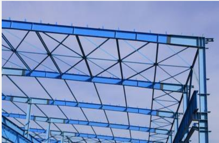
Poutre en I (Traverses/Beams)
