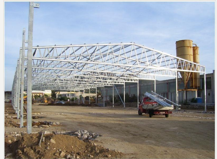
Poutre en treillis (Ferme/Truss)
