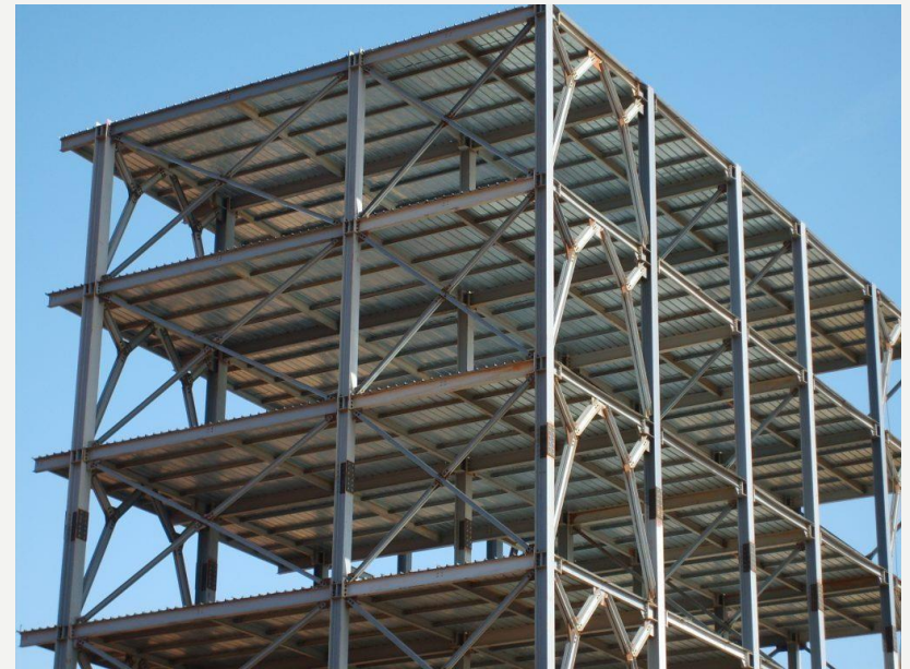
Bâtiment à étages métallique
