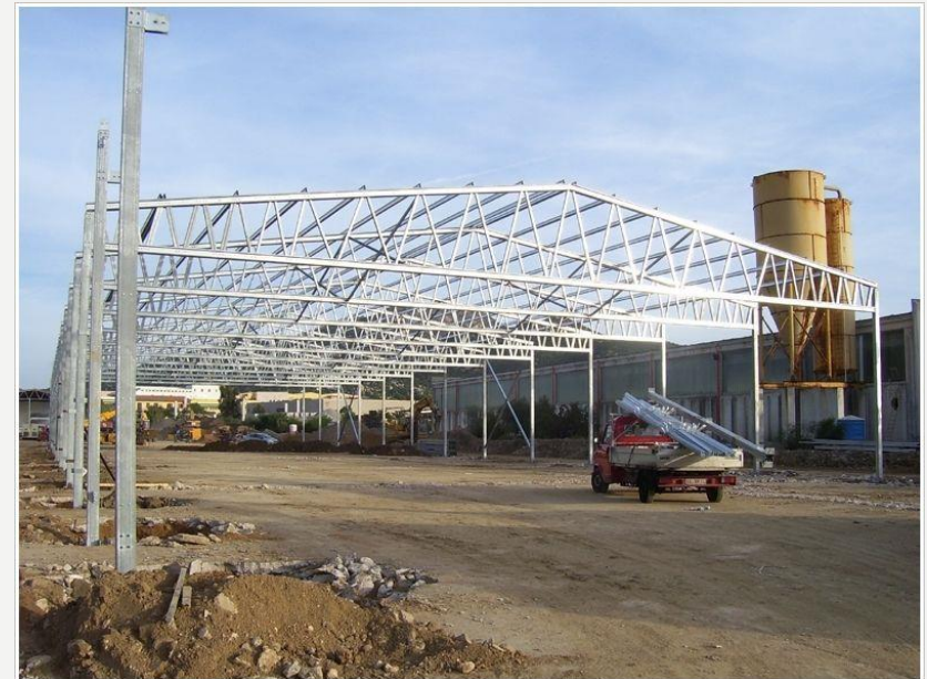
Poutre en treillis (Ferme/Truss)
