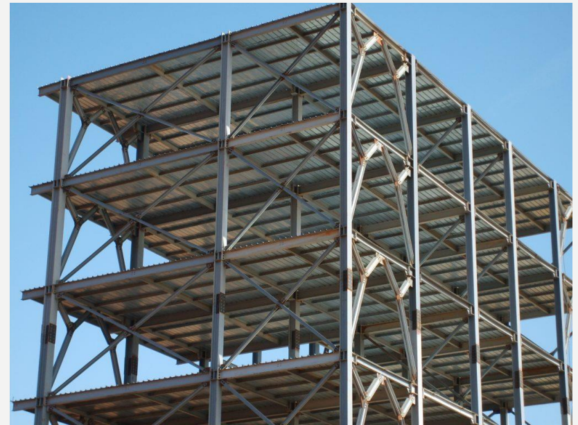
Bâtiment à étages métallique
