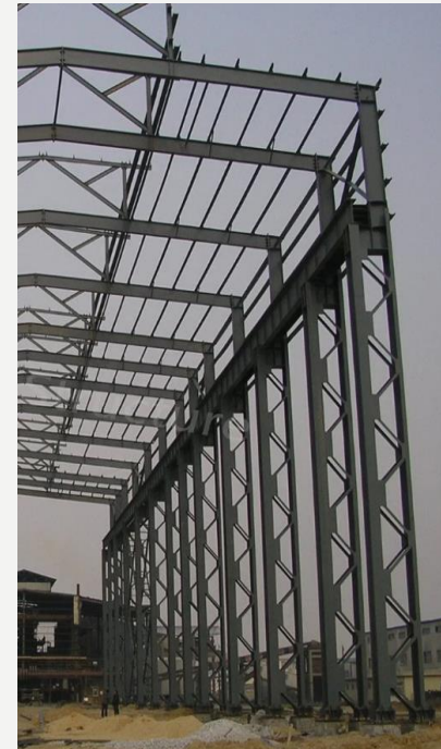
Poteau en treillis
