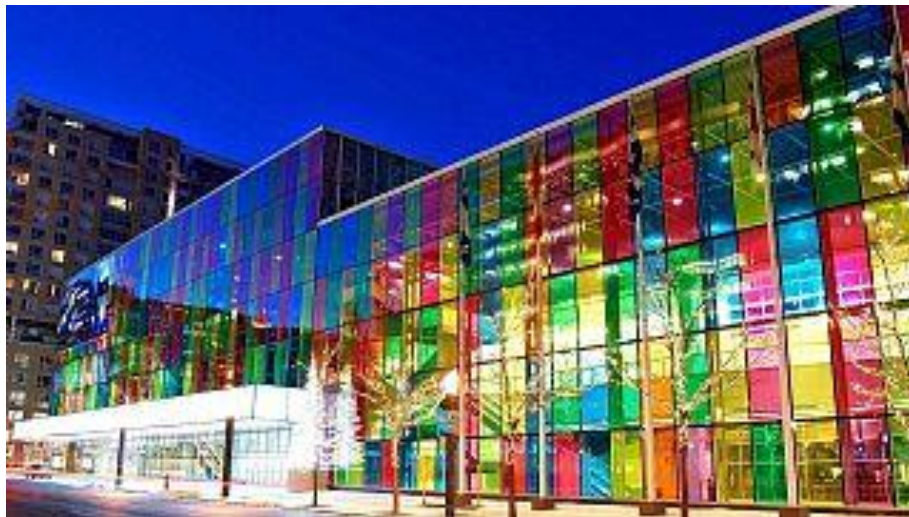
Figure V.11. Vitrage photovoltaïque coloré Source : Lottie Limb & Emmy Arpin Alotto 91
