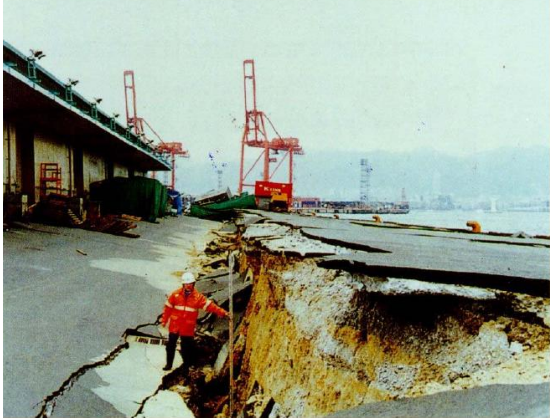
Liquéfaction dans un port au Japon
