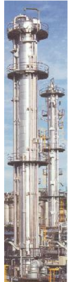
Colonne de distillation Echelle industrielle
