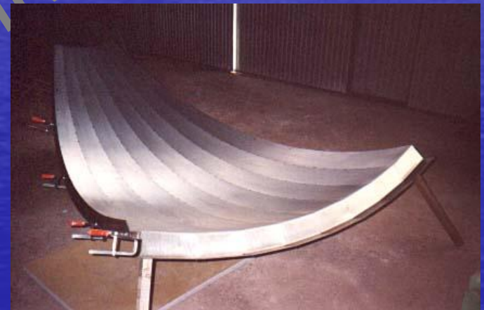
Vissage des bords du moule qui seront recouverts de résine. Ils serviront de plan de contact pour le joint et d'armature rigides.
