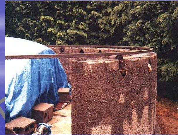
Cerceau sur lequel seront fixés les éléments de la coupole.
