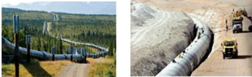
Fig.2.3 Type de mode de pose de pipeline
