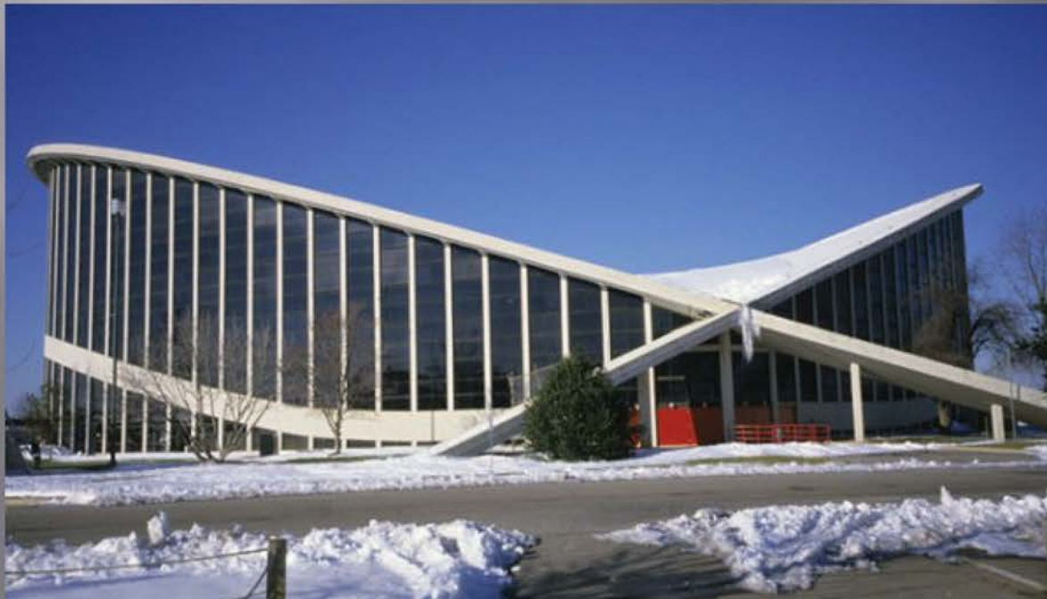
4.43 Palais des sports de Raleigh, Caroline du Nord, USA. Arcs soutenant une toiture suspendue.
