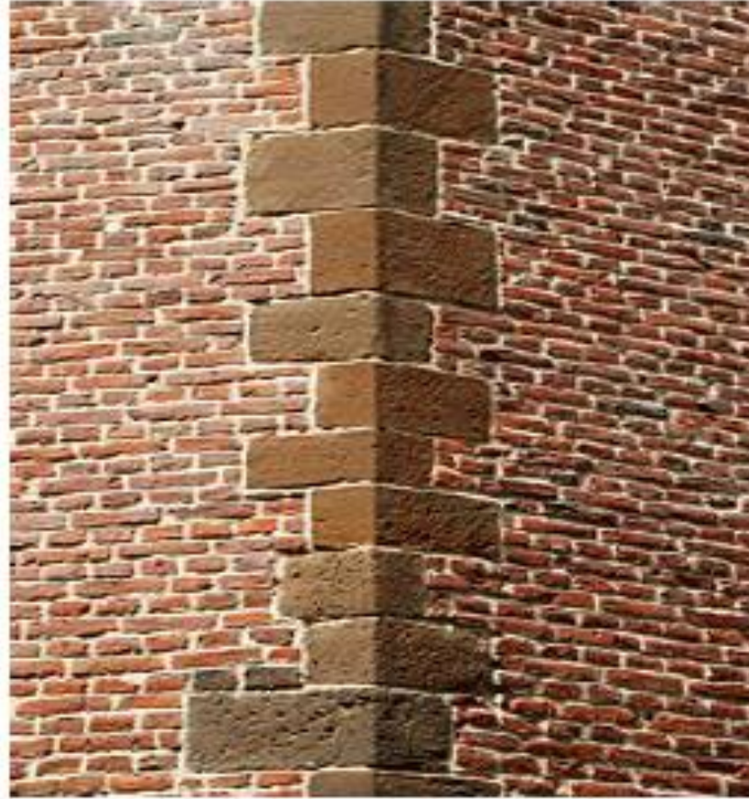
بناء زاوية الجدار بحجارة منحوتة مستطيلة.
