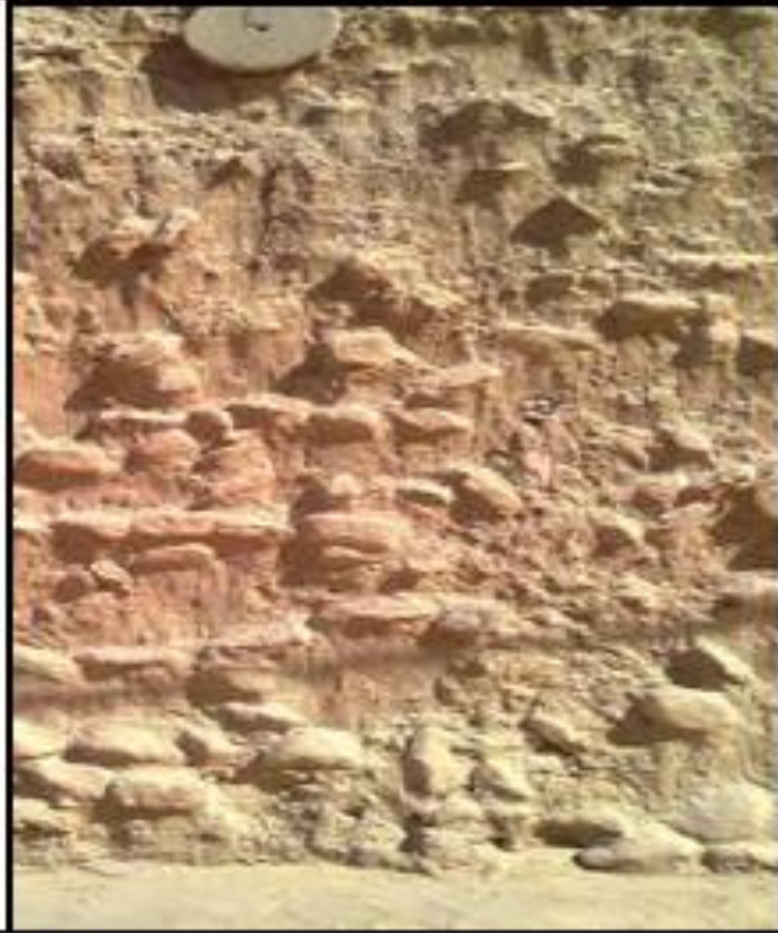
بناء بالحجارة فوق أرضية مستوية (توفاغي)
