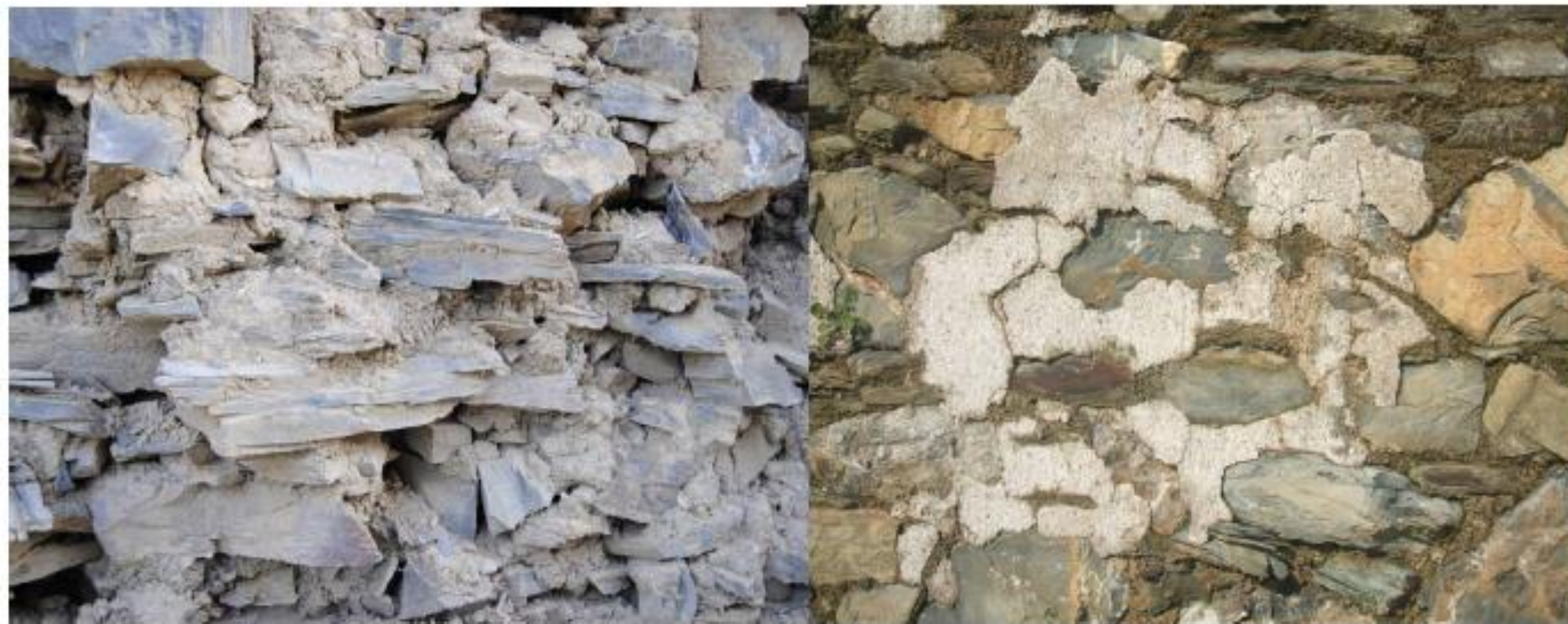
الصورة 2: استعمال الملاط في تلاحم الحجارة وتكسية الجدران.
