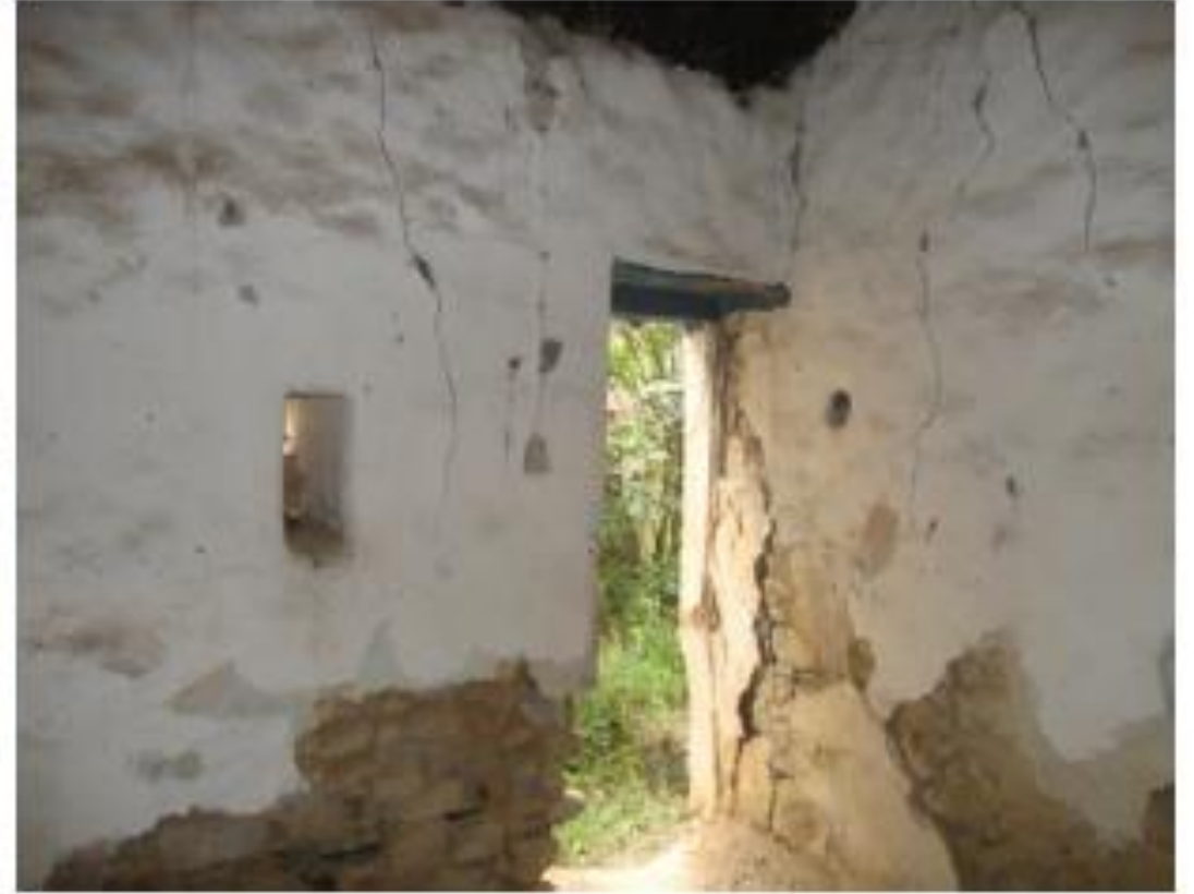
الصورة 6: مادة الجص في تكسية الجدران الداخلية للمساكن الريفية بالقرية القبائلية.
