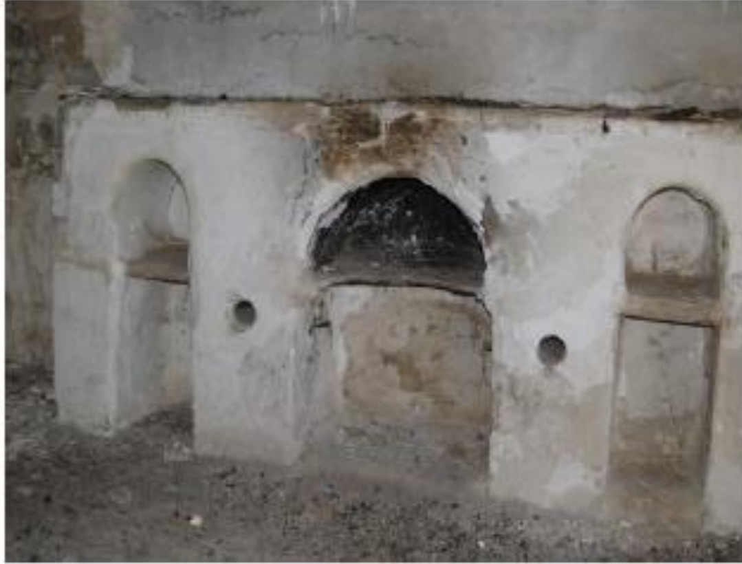
الصورة 6: مادة الجص في تكسية الجدران الداخلية للمساكن الريفية بالقرية القبائلية.
