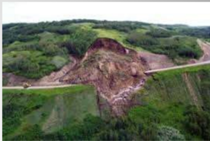
Glissement de terrain
