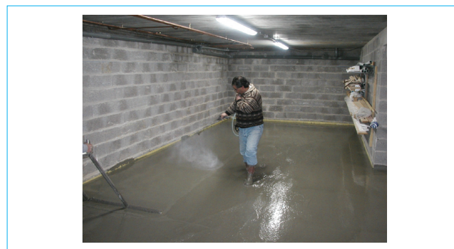
Figure 7 – Application d'une cure immédiatement après mise en œuvre du BAP
